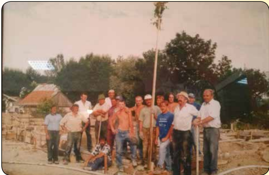
Budowa Remizy w Bukowsku
