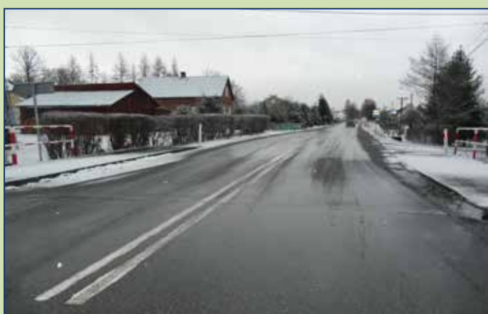
Wyremontowany odcinek drogi w Pobiednie
