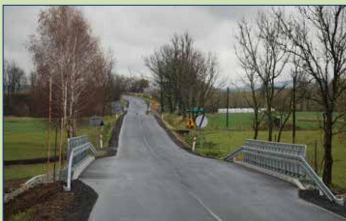
Wyremontowane 2 mosty i odcinek drogi Nagórzany - Bukowsko
