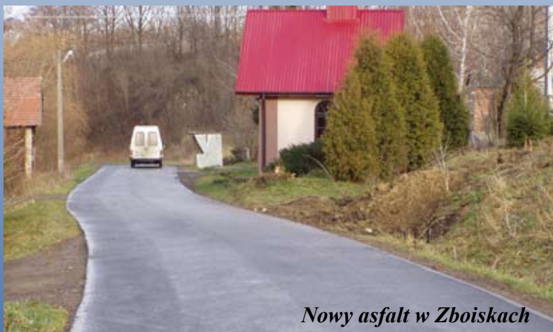
Budowa drogi do Tokarni
