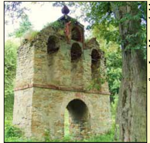
Dzwonnica przed remontem 2004r.
