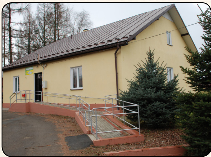
Dom Ludowy w Nagórzanach
